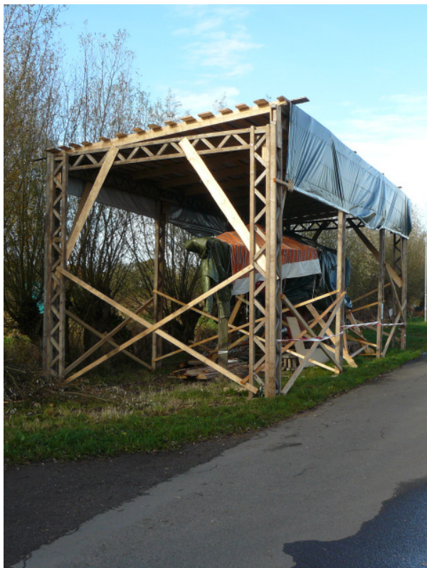
SVEA unter Dach und Fach
